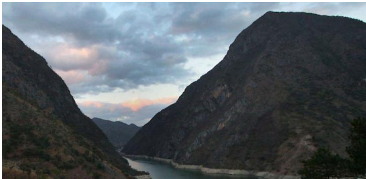
Staudamm Río Chixoy (Foto: James Rodriguez)
